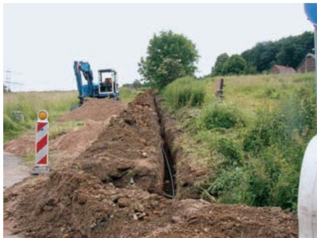
▲ Um auch entfernte Grundstücke an die Kanalisation anzubinden, wurden zusätzlich 35 Kilometer Druckrohrleitungen verlegt
