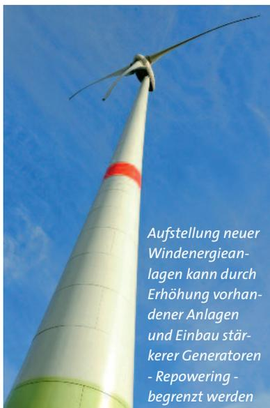
*Aufstellung neuer Windenergieanlagen kann durch Erhöhung vorhandener Anlagen und Einbau stärkerer Generatoren - Repowering - begrenzt werden*
