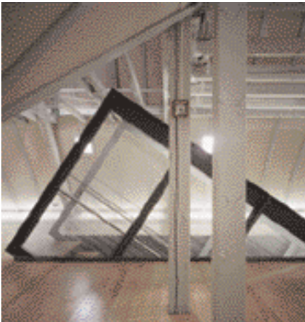
Durch einen „Tunnel aus Stahlgitter“ gelangt man von der Beletage auf den Dachboden
