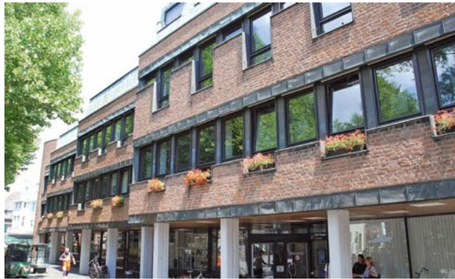
Das Rathaus der Stadt Kempen wurde von 1964 bis 1967 als horizontal gelagerter Stahlbetonskelettbau mit Backsteinverkleidung erbaut
