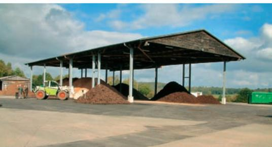
▲ Ein altes Hallendach wurde vor der Sanierung gesichert und deckt nun die neue Lagerfläche
