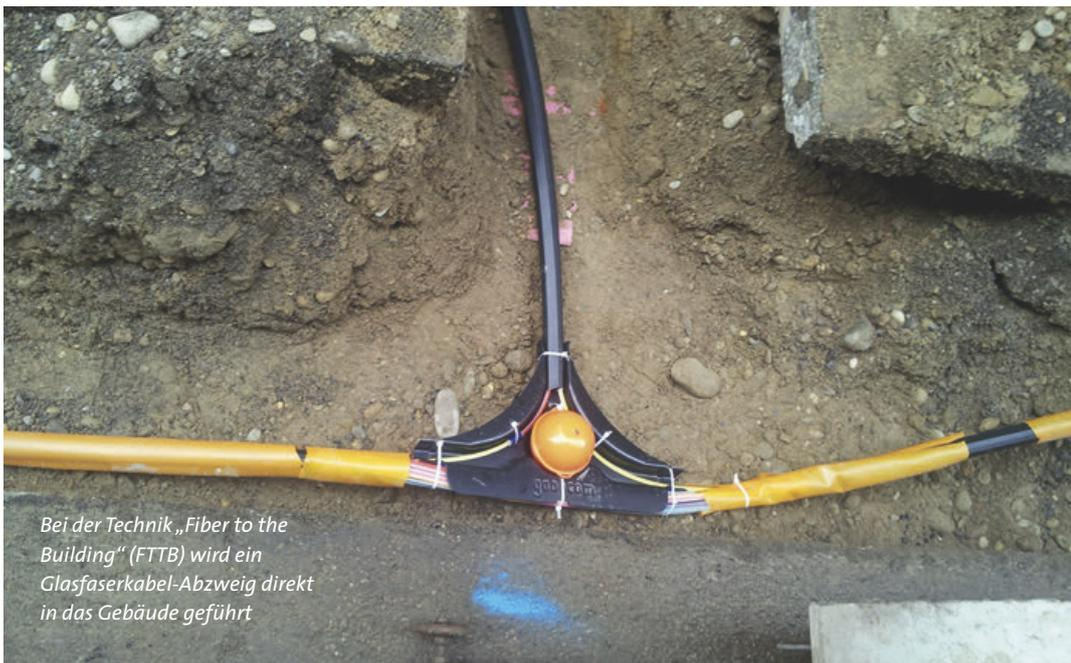
Bei der Technik „Fiber to the Building“ (FTTB) wird ein Glasfaserkabel-Abzweig direkt in das Gebäude geführt
