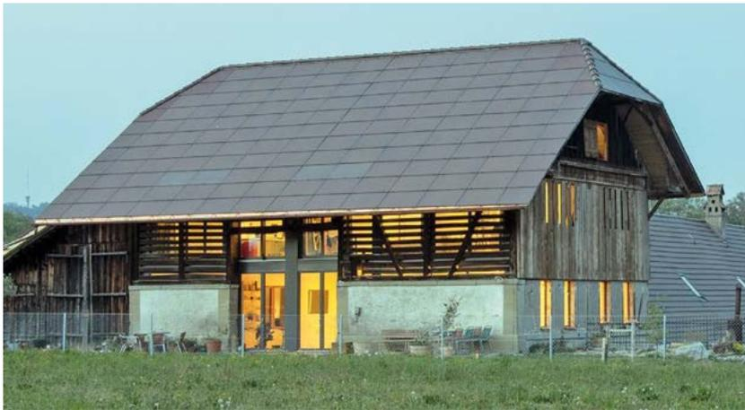
Der sanierte denkmalgeschützte Bauernhof Weyerguet bei Bern deckt seinen jährlichen Energiebedarf mit einer dachflächenintegrierten Solaranlage
