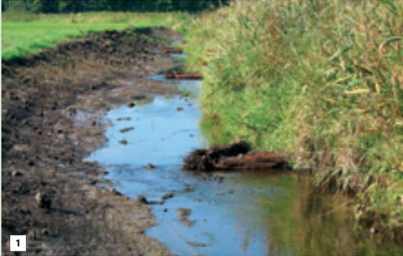
**Düsedieksbach / NSG Füllenbruch** in Herford-Hiddenhausen (Bild 1): Mit dem Ziel, eine Sohlaufhöhung und eine eigendynamische Gewässerentwicklung zu initiieren, wurden rechtsseitig **Strömungslenker** aus Erlenfaschinen eingebracht und das linksseitige Ufer deutlich abgeflacht.
