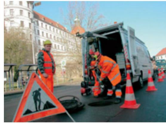
▲ Bei nicht begehbaren Abwasserkanälen übernehmen Roboter den Einbau der Kabel
