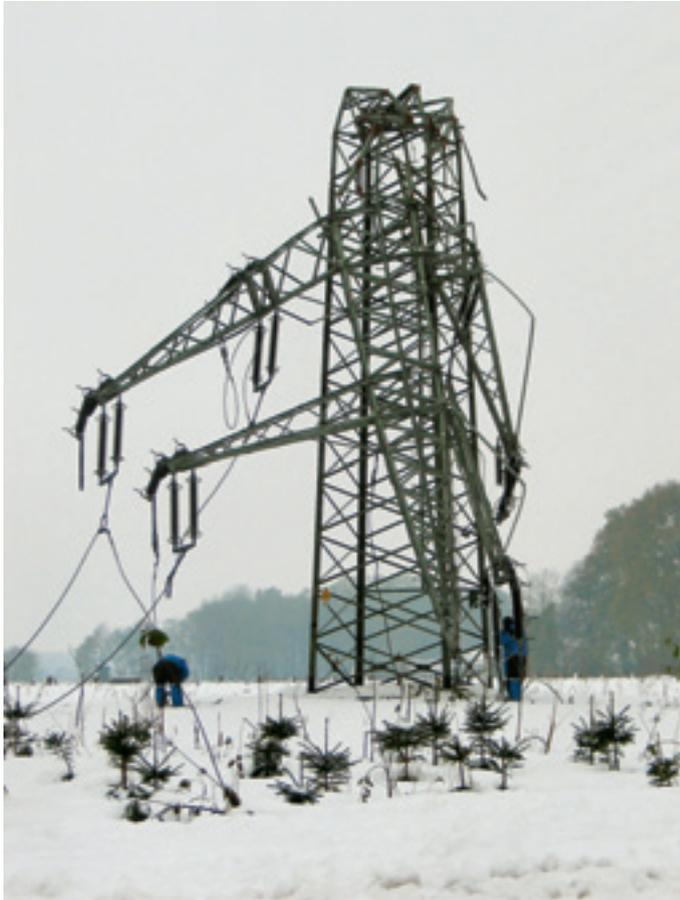
*42 Strommasten knickten am 25. November 2005 zwischen Gronau und Metelen unter der hohen Schnee- und Eislast um*
