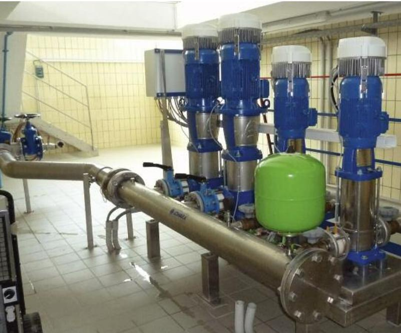
◀ Eine Druckerhöhungsstation, die zur Versorgung einiger Ortsteile nötig ist, wurde im Jahr 2014 erneuert
