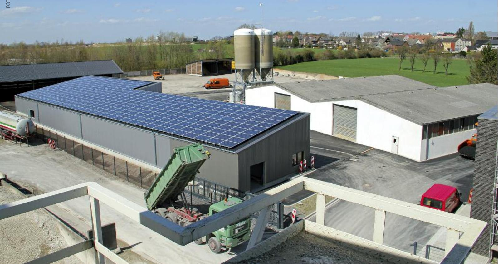
▲ Dank Hackschnitzelheizung und Photovoltaikanlage ist der Baubetriebshof in Beckum energieautark
