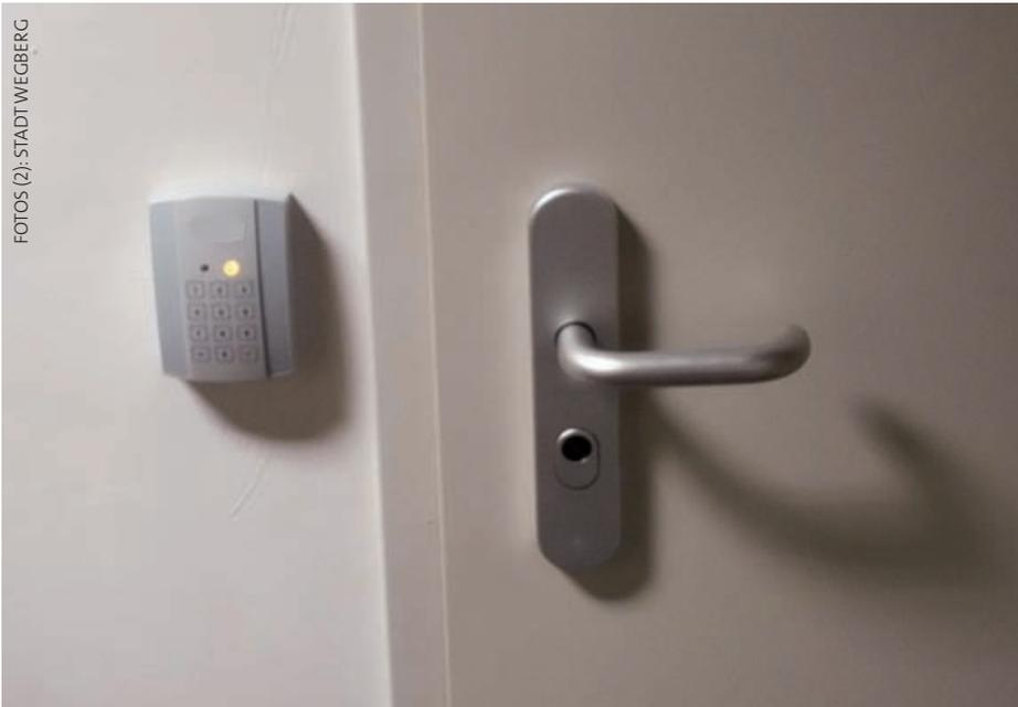
▲ Zur Sicherung von Technik und Daten im Serverraum hat die Stadt Wegberg eine Brandschutztür eingebaut und diese an die Zeiterfassungsanlage angeschlossen
